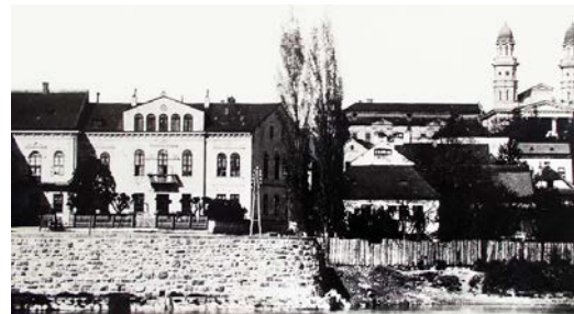
Рис. 27. Підпірна кам'яна стінка на початку сучасної Ботанічної набережної до будівництва синагоги (кінець ХІХ ст.). (Literati 2022b)
