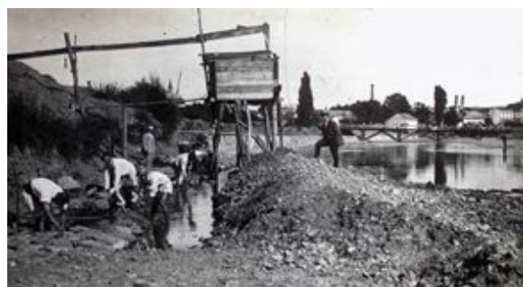
Рис. 19. Спорудження кам'яної протипаводкової стіни в районі сучасної набережної Незалежності. 1920-ті роки (з фондів Закарпатського обласного краєзнавчого музею ім. Т. Легоцького)
