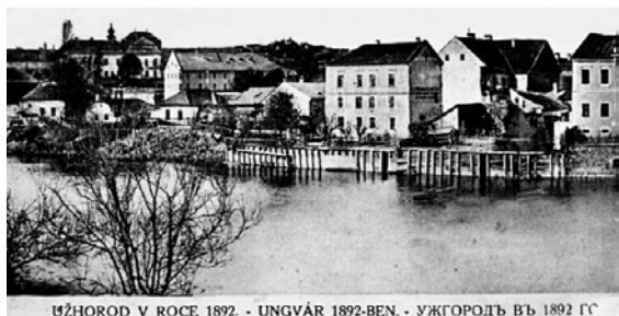
Рис. 17. Ділянка правого берега Ужа біля пішохідного мосту, частково захищена протипаводковою стіною – дерев'яною і кам'яною (почали мурувати в 1879 р.), 1892 рік. (Literati 2020a)
